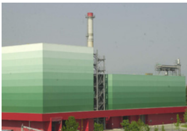
impianto di incenerimento.
